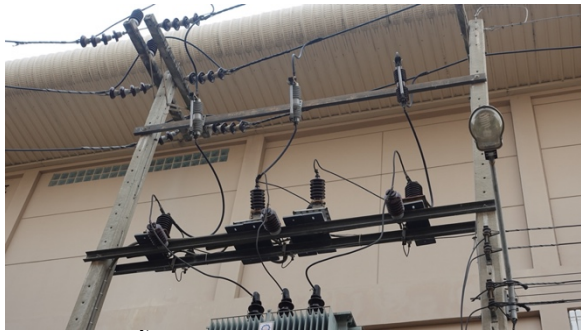
การติดตั้ง Dropout Fuse/Lightning Arrester
