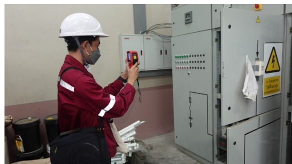
ตรวจวัดอุณหภูมิด้วยคล็องอินฟราเรด MDB-2
