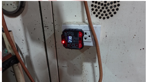
ตรวจสอบระบบไฟฟ้าของเต้ารับอาคาร
