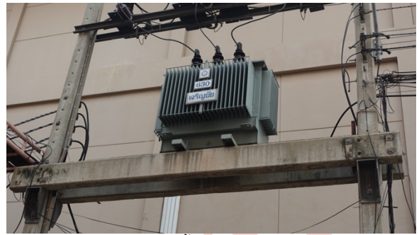
ลักษณะการติดตั้งแบบนั่งร้านหม้อแปลง
