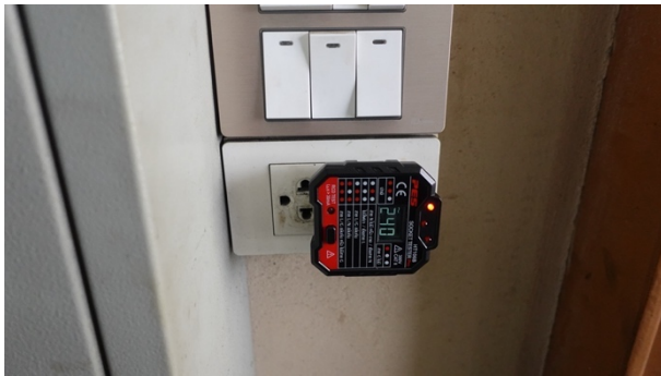
ตรวจสอบระบบไฟฟ้าของเต้ารับอาคาร
