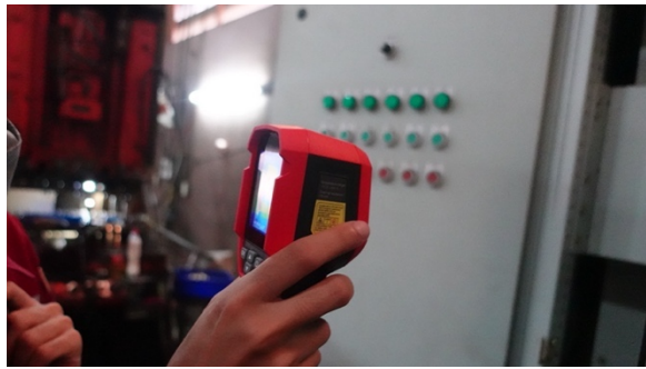
ตรวจวัดอุณหภูมิด้วยกล้องอินฟราเรด MDB-3
