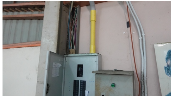
ตรวจสอบการติดตั้งอุปกรณ์ภายในตู้
