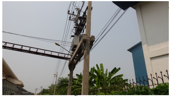
ลักษณะการติดตั้งแบบนั้งร้านหม้อแปลง
