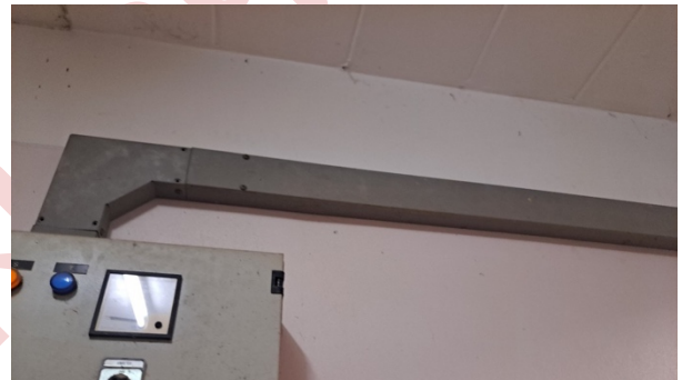
การเดินสายแรงต่ำผ่านรางเคเบิล (Wireway) MDB-4
