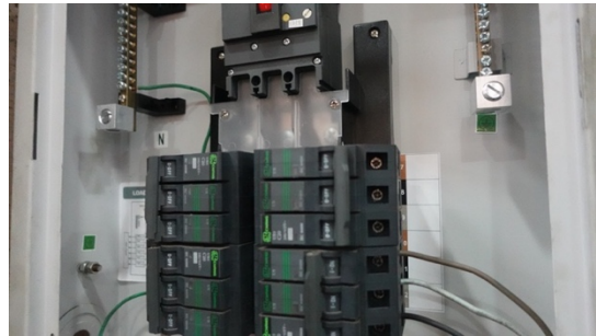
ตรวจสอบการติดตั้งอุปกรณ์ภายในตู้
