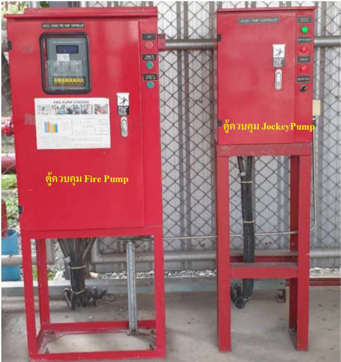
ตู้ควบคุม Fire Pump และ Jockey Pump
