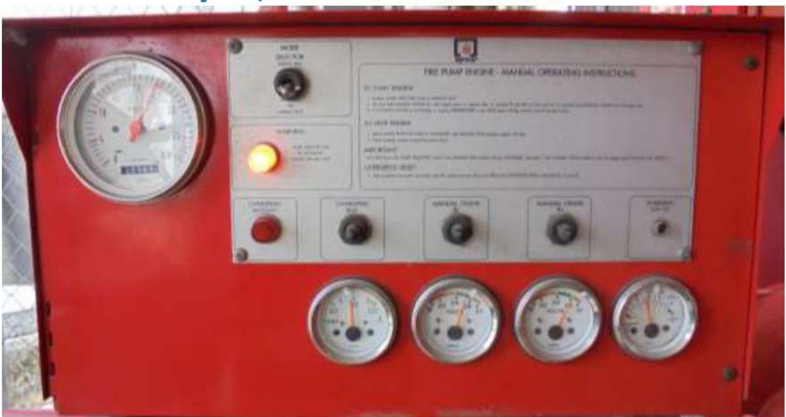
ตู้ควบคุม Fire Pump และ Jockey Pump
