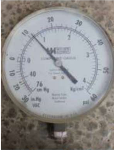
เกจวัดความดันทางด้าน ดูดของปั้มน้ำดับเพลิง
